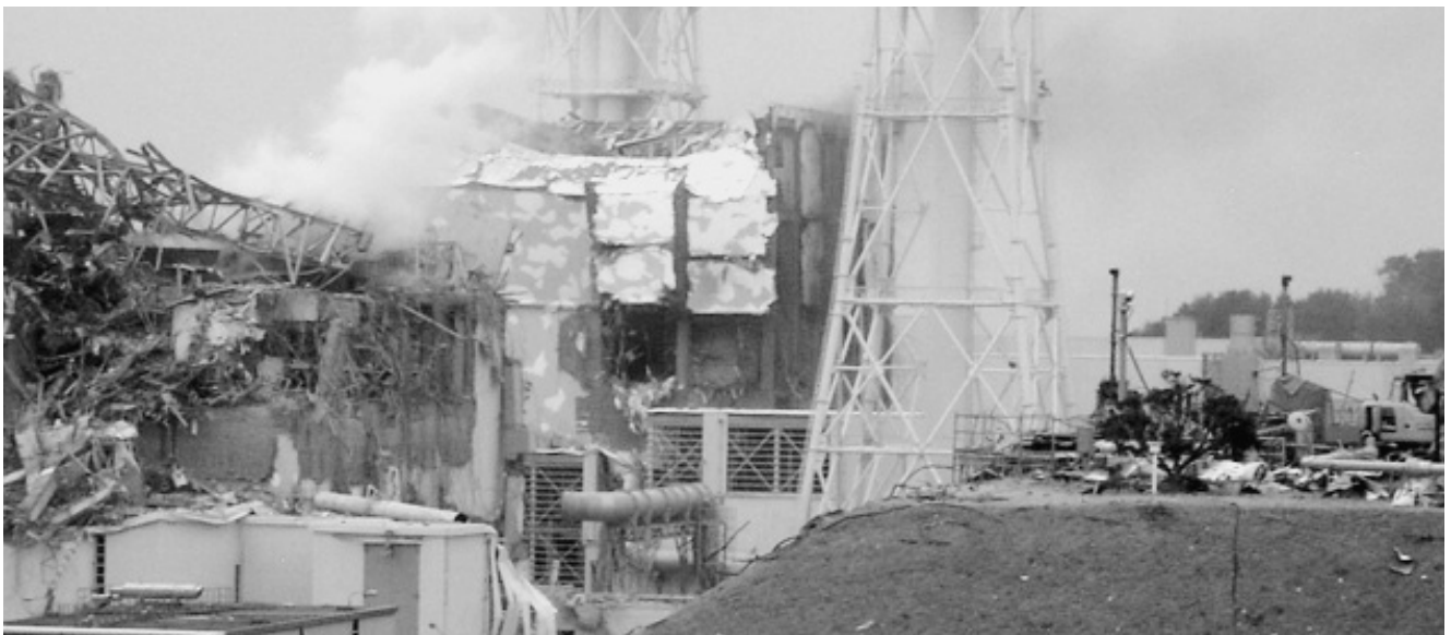
4号機 2011.3.15 写真提供：東京電力株式会社
