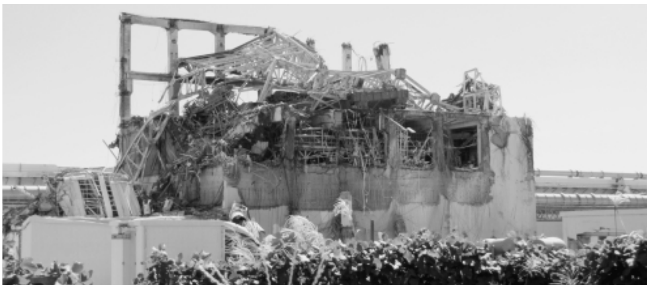
3号機 2011.9.24 写真提供：東京電力株式会社
