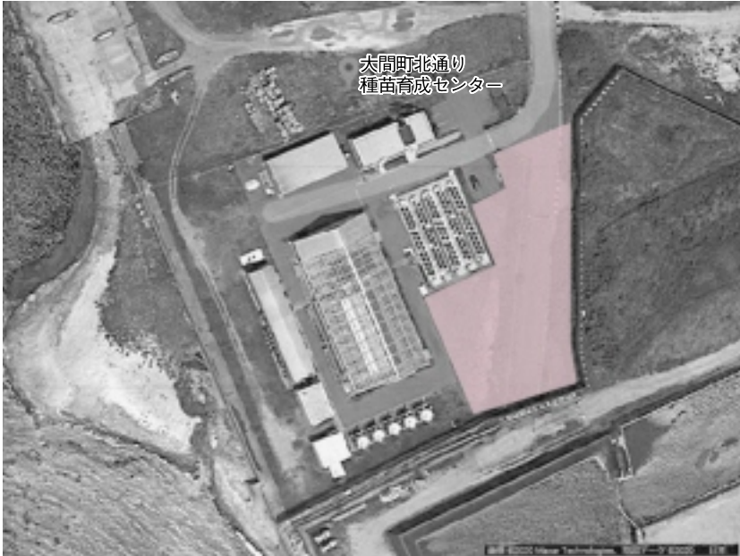
〔参考写真〕北通り種苗育成センター周辺の太陽光発電設備設置位置(ピンク部分)
