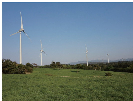
大間風車全景（手前より2～9号）
