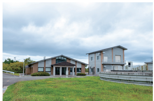
大間町浄化センター
