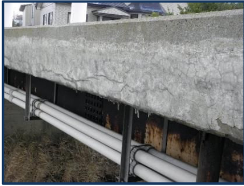
凍害※2と思われる損傷（参考例）
