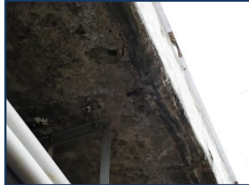
凍害※2と思われる損傷（参考例）
