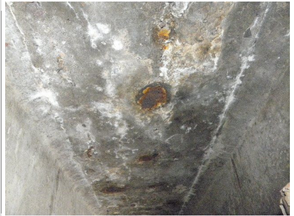
写真6 床版の損傷
