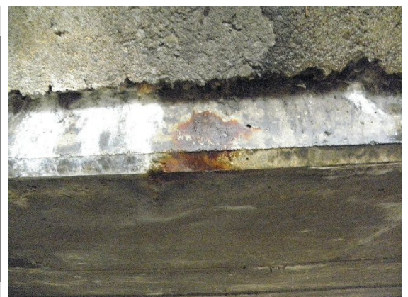
写真4 主桁の損傷
