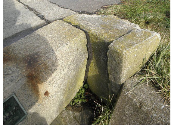
写真8 橋台の損傷
