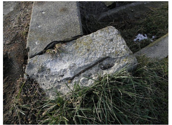
写真9 橋台の損傷
