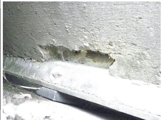
写真7 横桁の損傷
