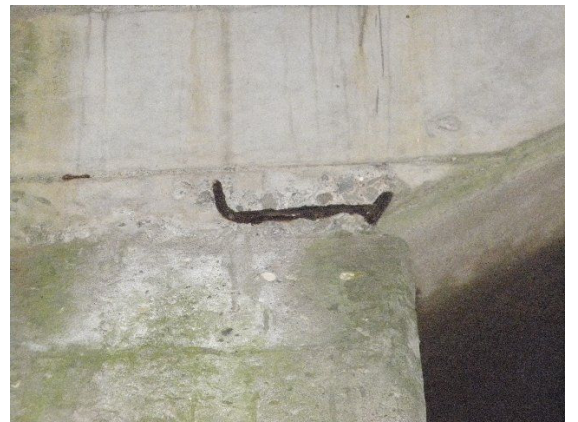
写真10 橋台の損傷
