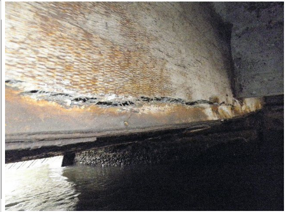
写真5 主桁の損傷
