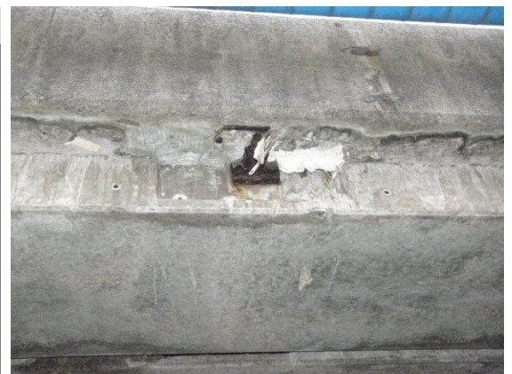
写真3 横桁の損傷
