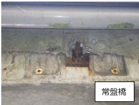
写真1 横桁の損傷
