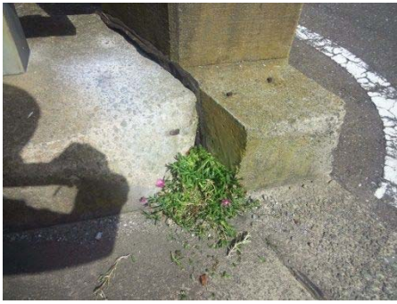
写真7 地覆の損傷
