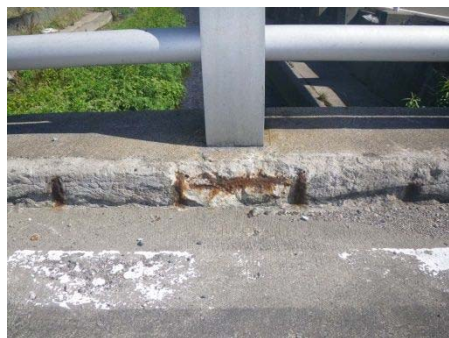
写真6 地覆の損傷
