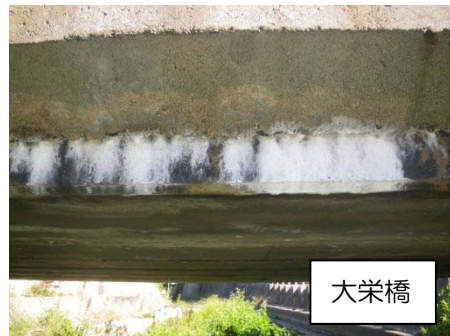
写真2 主桁の損傷
