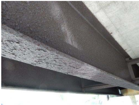
写真1 主桁の損傷
