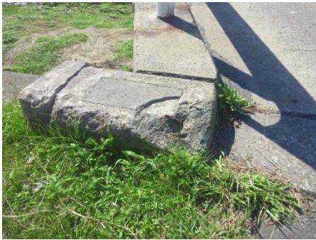
写真9 胸壁の損傷
