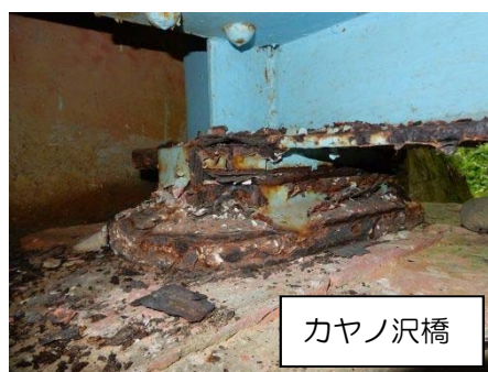
写真3 支承の損傷
