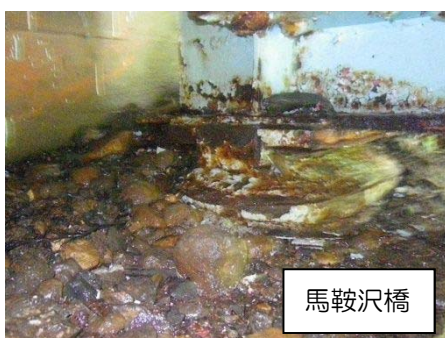
写真2 支承の損傷
