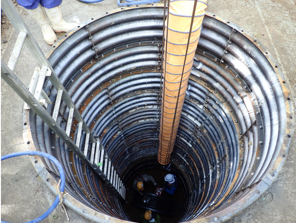
奥戸川導水管推進工事
